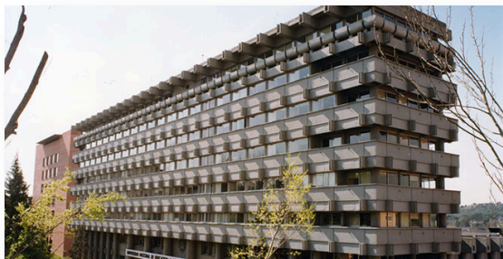
Edificio de Humanidades Campus Senda del Rey
