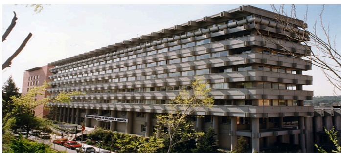
Edificio de Humanidades Campus Senda del Rey
