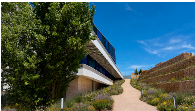
Imágenes del estado de las instalaciones en el Campus de Las Rozas
