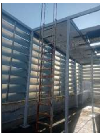
03 Escala acceso tramex en cubierta
