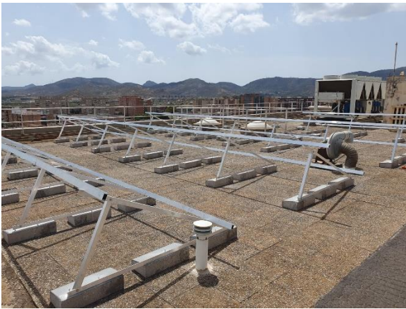
Instalación de perfiles
