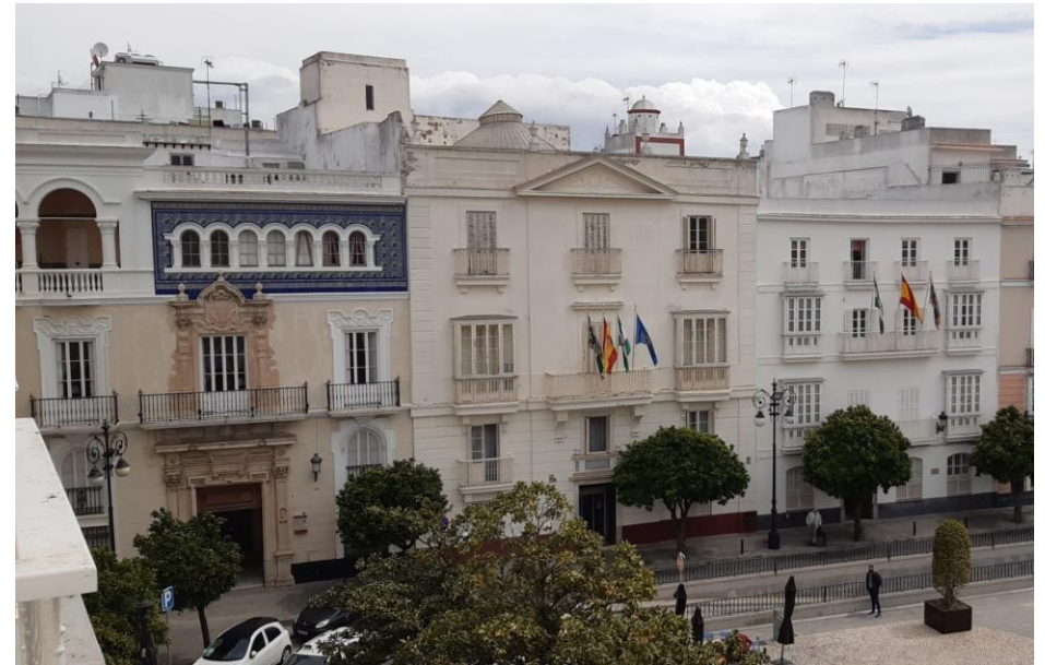
Edificio Centro Asociado UNED Cádiz
