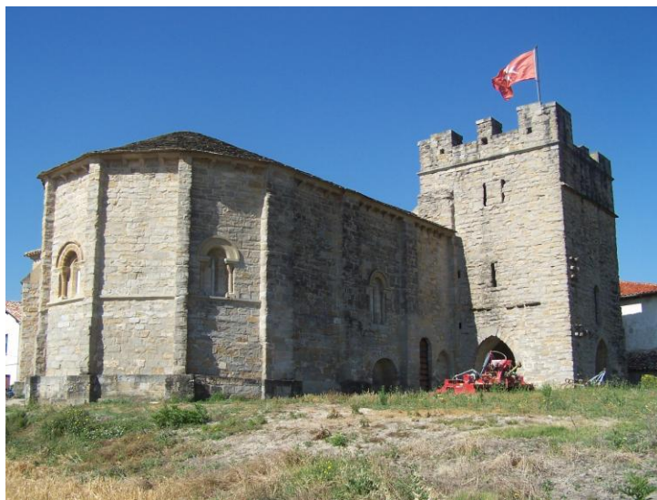
Exterior de la iglesia de San Miguel Arcángel en Cizur Menor (Fot. Wifredo Rincón García).
