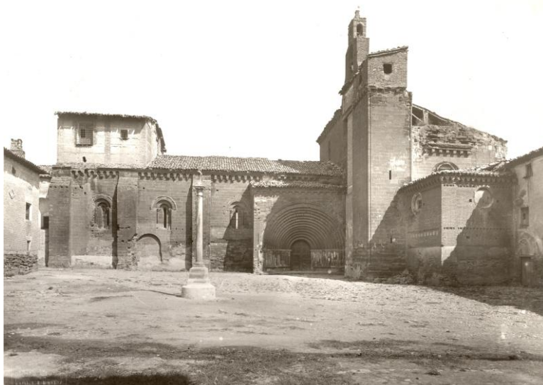
Fotografía antigua de la fachada Sur de la iglesia del Monasterio de Santa María de Sigüenza.
