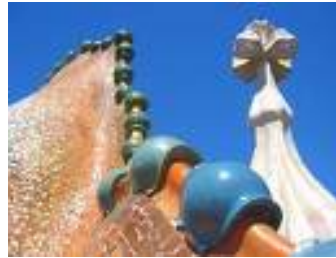
Detalle del tejado de la Casa Batlló.
