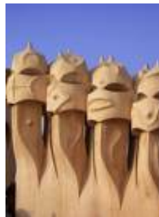
Detalle de las chimeneas de la La Pedrera.
