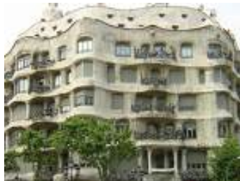
Exterior de La Pedrera.
