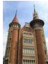
Casa Terrades. Conocida como Casa de les Punxes.
